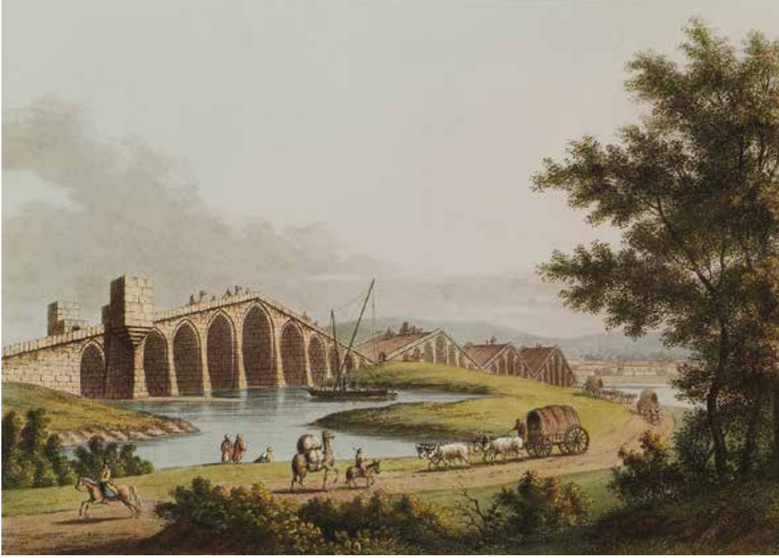
Kervan yolları üzerinde inşa edilmiş Büyükçekmece Köprüsü, İstanbul.
